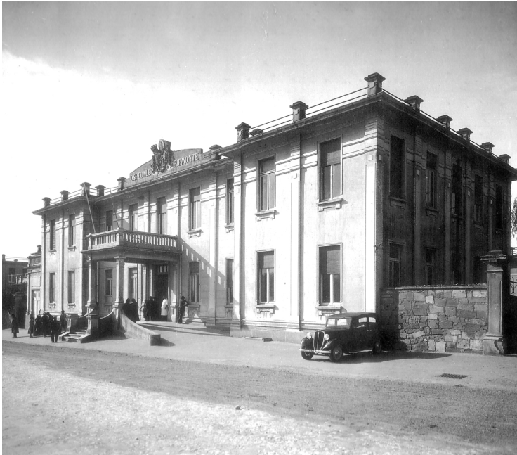
Il Grande Ospedale Civico Piemonte in una fotografia di Crivellaro del 1939, prospetto anteriore. Messina, collezione privata
